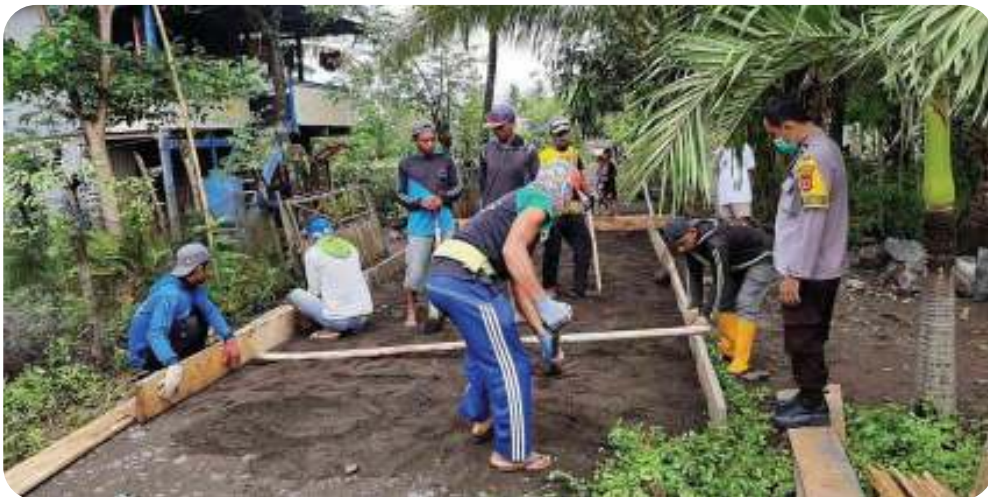
Gambar 2.4. Contoh Pembangunan Jalan di Perdesaan
