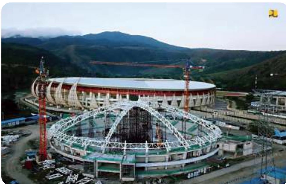
Gambar 1.2. Pembangunan Fasilitas Olahraga di Papua Sumber: Kementerian PUPR/eppid.pu.go.id (2020)
